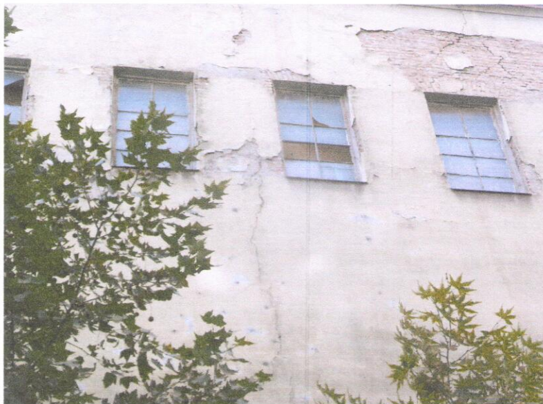
დაზიანებული ჩვეულებრივი ზღუდარი აგურის ჩამკეცით.
