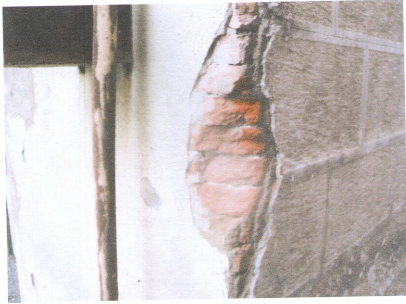
დანარჩენ ფასადზე, პირველი სართულის დონეზე, ქვიშა-ცემენტის ნალესის შემდეგ დატანილია მოპრკეთების შრე.
